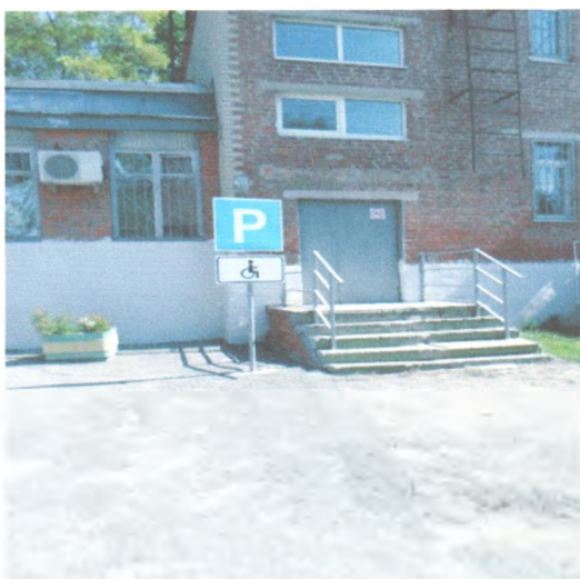
Фото 17. Наружный лестничный марш
