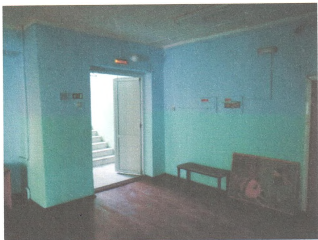
31. Лестничный марш и эвакуационный выход
