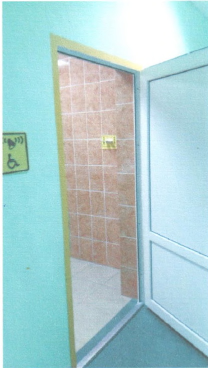
Фото 27. Дверь в санузел.
