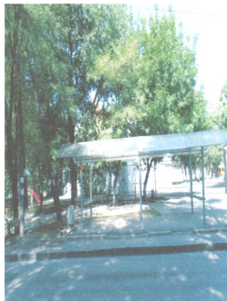
Фото 2. Общий вид остановочного комплекса
