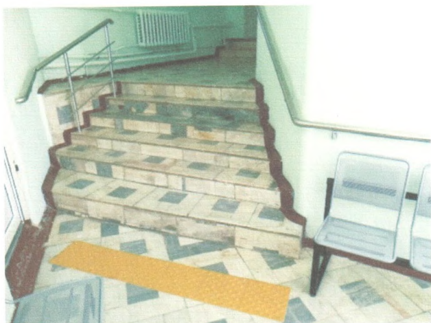
33. Лестничный марш внутри здания
