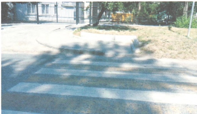
Фото 5. Общий вид по пути движения
